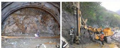
隧道口崩積岩層加固
