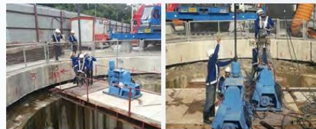
豎井封底注漿
