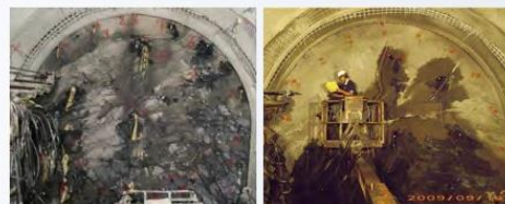
隧道內破碎岩層加固
