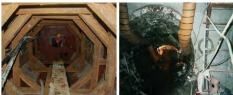
豎井側壁注漿
